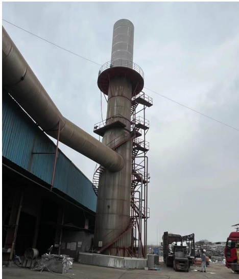
图 3 熔炼废气排放口（DA005）
