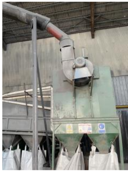
图 2 脉冲布袋除尘器（处理筛分进料粉尘、筛分粉尘）
